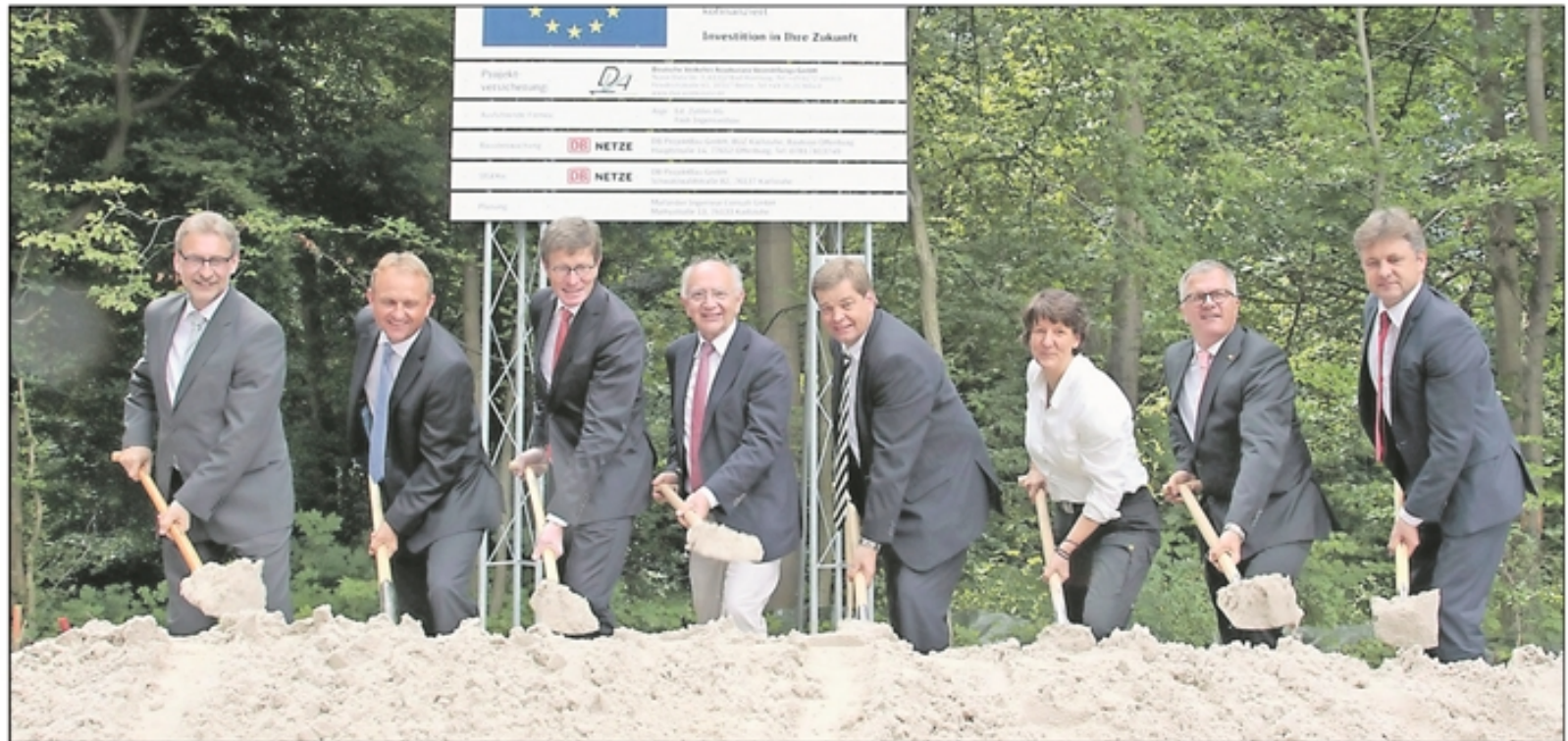
Die symbolischen ersten Spatenstiche setzen Vertreter der Bahn und der Politik im Wald bei Niederbühl.
