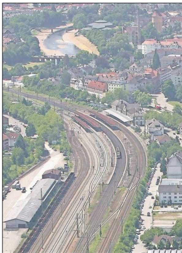
Schnellbahn-Bremse: Die Kurve im Rastatter Bahnhof als „Nadelöhr“ im transeuropäischen Schienennetz – und Mit-Auslöser für die Tunnel-Planung.
